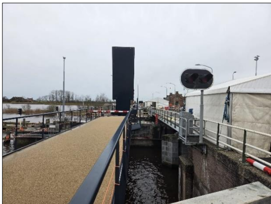
Reitdiepbrug en N388
