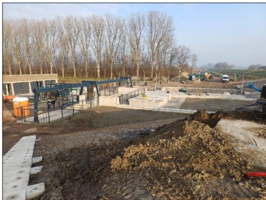
Foto's gemaal en sluis
